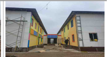
유치원 에너지효율 개선 후 전경 2
