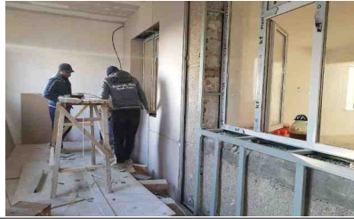
(KEA측) 건물 벽체 단열 공사
