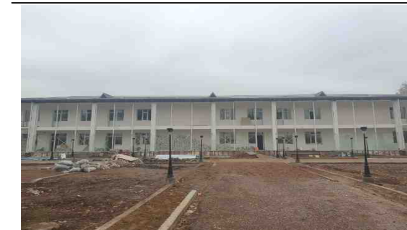
유치원 에너지효율 개선 후 전경 1
