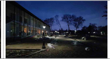
태양광 LED조명 설치 후 2
