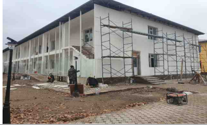
(KEA측) 태양광 LED조명 설치 1
