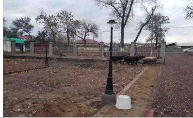
(KEA측) 태양광 LED조명 설치 2
