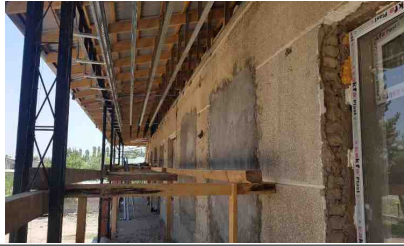
(우즈벡측) 건물 벽체 기초 공사
