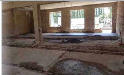
(우즈벡측) 건물 바닥 기초 공사
