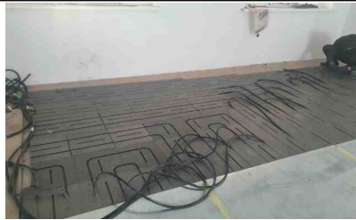
(KEA측) 건물 바닥 난방시스템 공사
